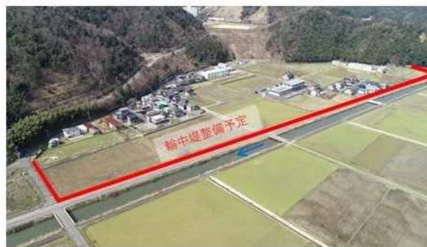
輪中堤整備（北川水系江古川）
