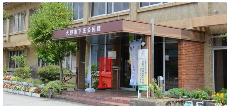
下庄公民館（R4年度設置箇所）
