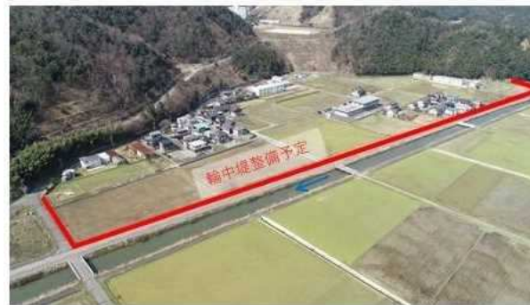
輪中堤整備(北川水系江古川)
