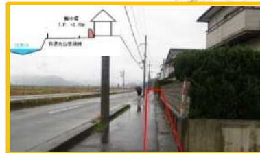
江古川地区の輪中堤整備(福井県)
