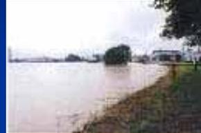
●堤体は安全性を維持しているものの、堤体土質が砂質土であるが故に、浸潤域は拡大している。
