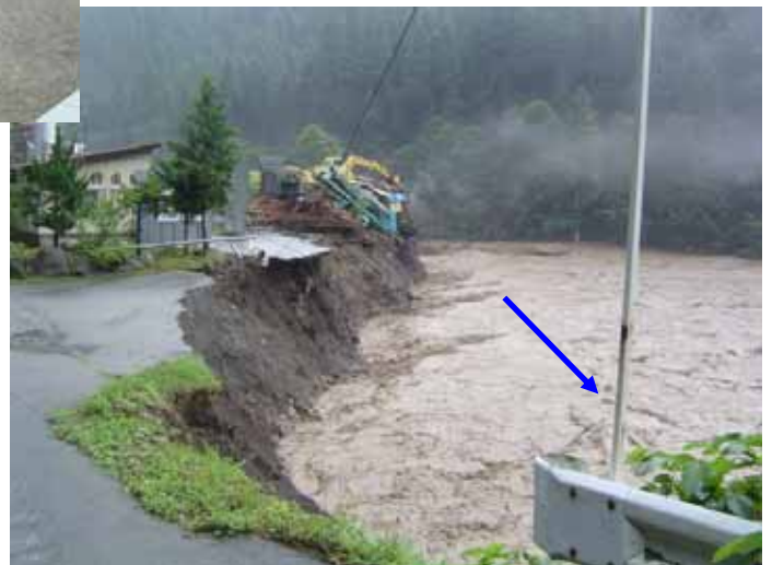
写真 - 池田町持越付近の河岸侵食状況
