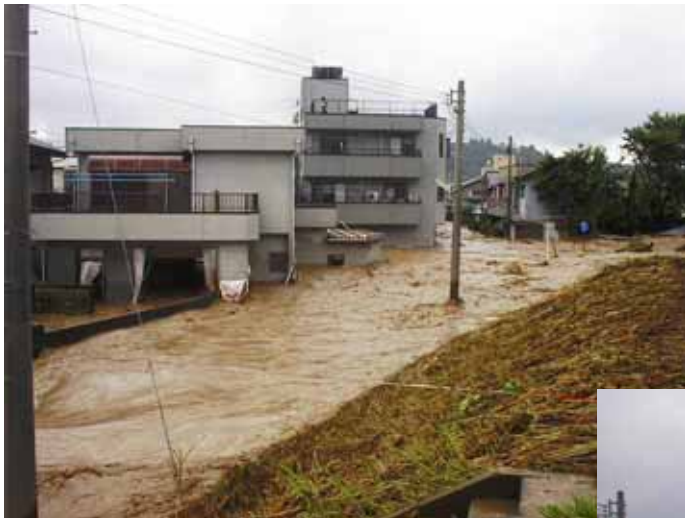
写真 - 破堤部から堤内側へ流入する濁流
