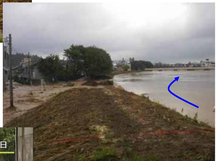
写真 - 破堤部の状況
