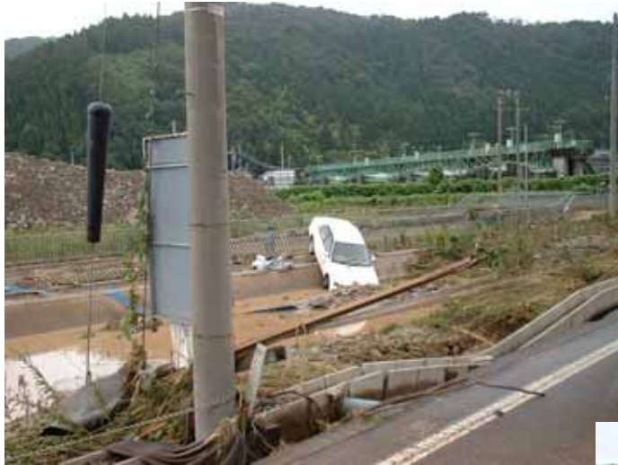
写真 - 足羽堰堤付近左岸堤内地の被災状況
