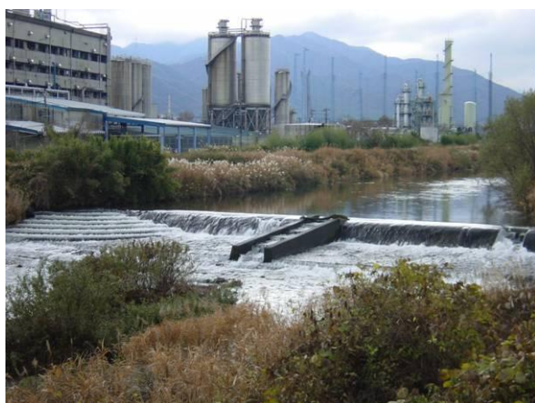
笙の川河口より約 2.2km の三島堰
