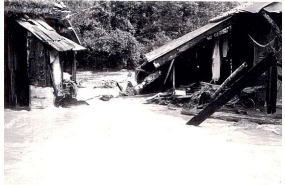
助高川の被害
