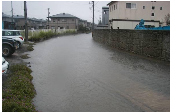
木の芽川支川深川の内水被害（敦賀市布田町）
