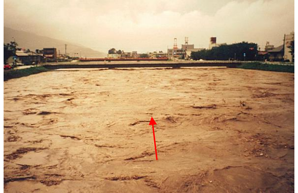
笹の川来迎寺橋付近の洪水時河川水位状況
