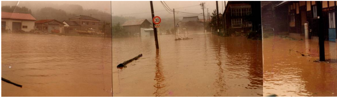
七瀬川流域(福井市大年町付近) 昭和56年7月3日 出水
