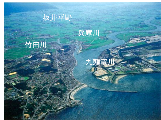
九頭竜川（坂井市三国町付近）
