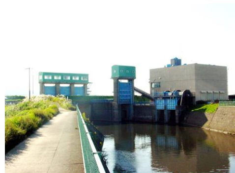
磯部川 排水機場と逆流防止水門 （坂井市春江町安沢）
