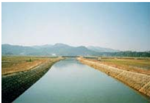
片川 放水路（福井市波寄町）
