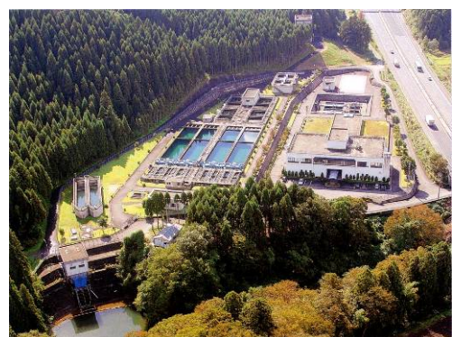
坂井地区浄水場(坂井市丸岡町山久保)
