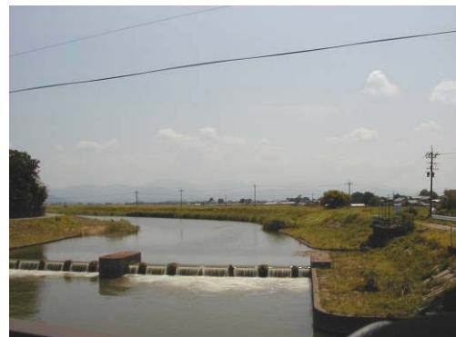
兵庫川 井場頭首工(坂井市坂井町今井)
