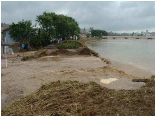
足羽川流域（福井市春日付近：破堤） 平成16年7月18日 出水
