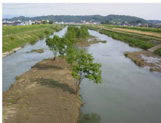
足羽川 樹木伐採（福井市大瀬町）
