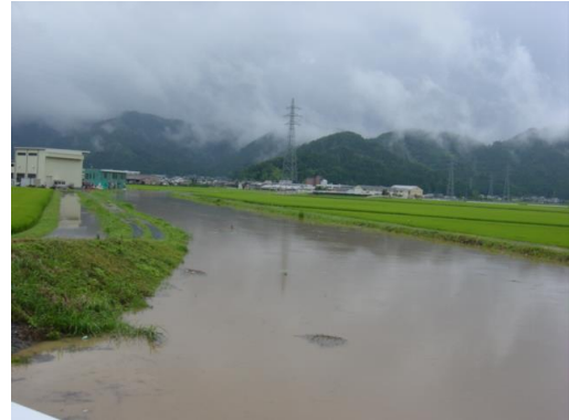
日詰川流域（大野市牛ヶ原付近） 平成 16 年 7 月 18 日 出水
