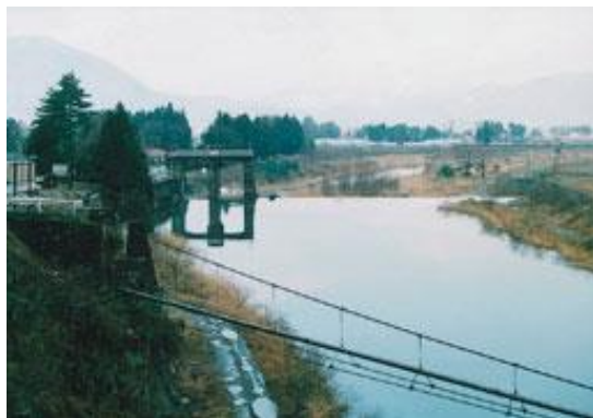
真名川用水頭首工（大野市五条方）
