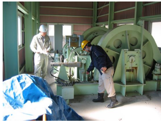
笹生川 ダムゲート巻上げ機点検 (大野市本戸)
