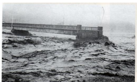
真名川流域 (大野市佐開付近) 昭和 40 年 9 月 13～16 日 出水
