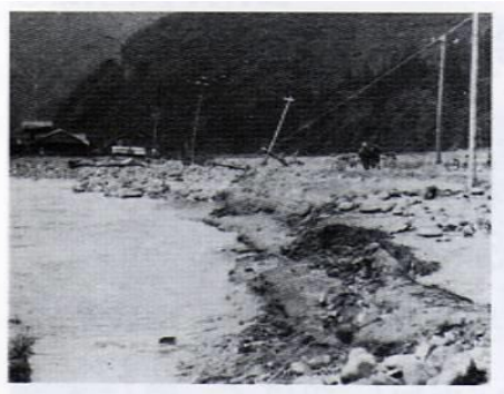
九頭竜川流域 (大野市朝日付近) 昭和 34 年 9 月 25～27 日 出水
