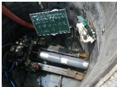
推進工法(開削しない方法) による管布設工事【福井市】
