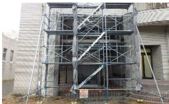
処理場(沈砂池管理棟)耐震補強工事【小浜市】
