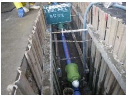
開削による管布設工事【福井市】
