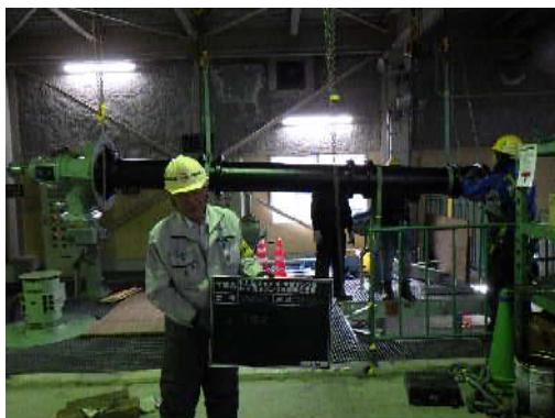
汚水ポンプ長寿命化工事(ポンプ据付状況) 【福井市】
