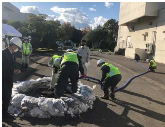
2) 仮設ポンプデモ演習
