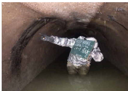
管路点検状況【福井県流域】
