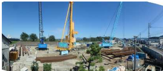
R2年10月時点(仮設構造物築造中)
