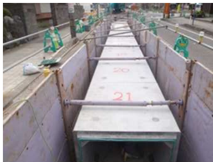
雨水管きよ整備中
