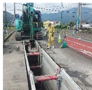
開削による管布設工事【敦賀市】
