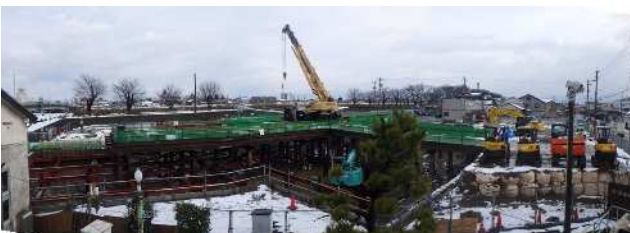
R3年1月時点(掘削作業中)
