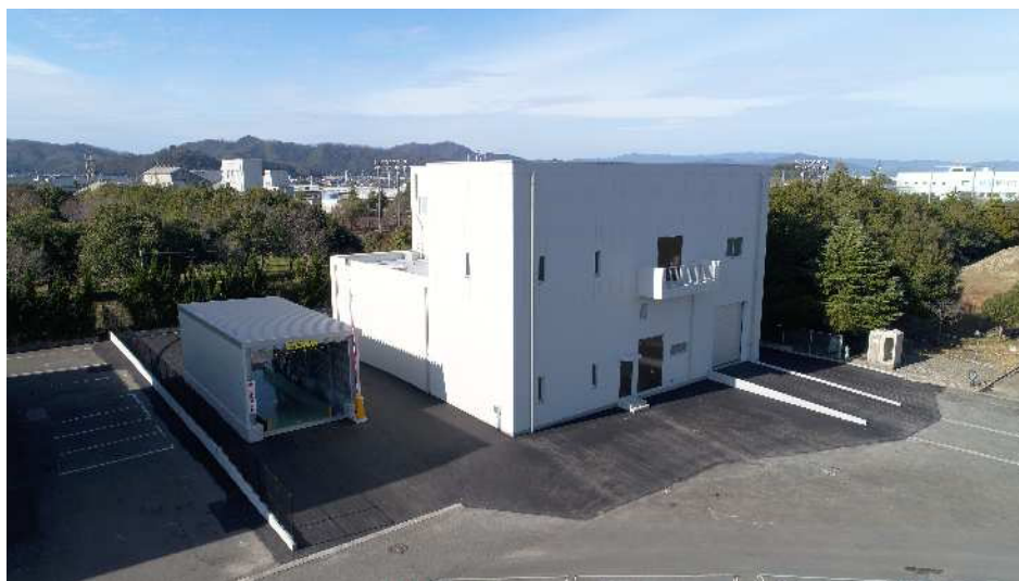
家久浄化センター汚泥前処理施設建設工事【越前市】 (し尿と下水汚泥を共同処理)
