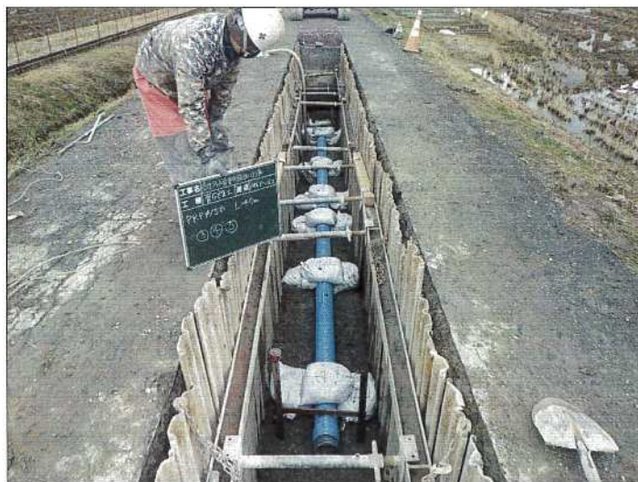
管敷設工事【あわら市】
