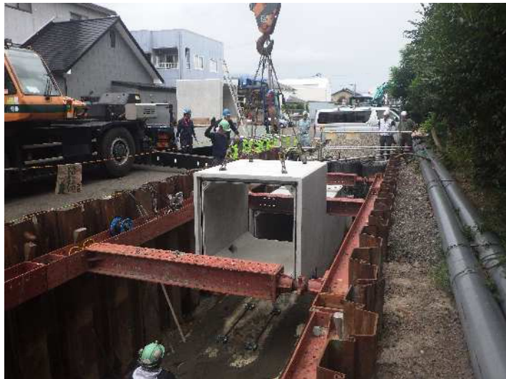
雨水管きよ（開削）整備工事【敦賀市】
