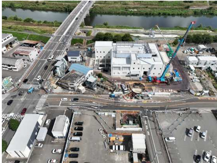
加茂河原ポンプ場更新工事【福井市】
