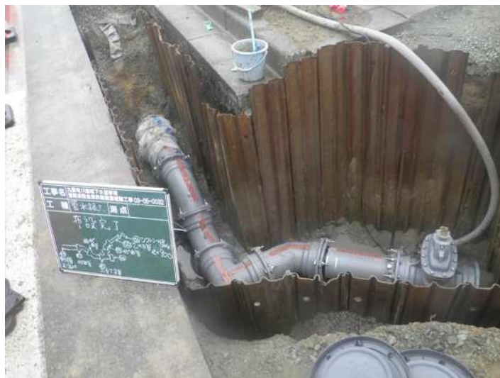
金津幹線耐震補強工事【九頭竜川流域下水道】
