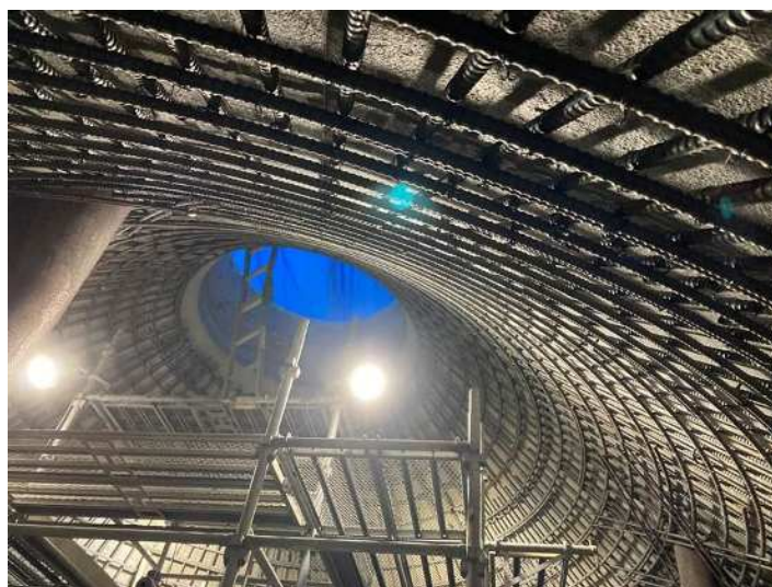
汚泥消化タンク耐震補強工事【九頭竜川流域下水道】
