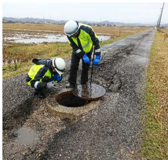
下水道管渠の一次調査【石川県津幡町】
