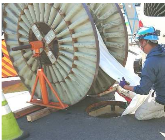
管更生（掘削せずに下水道を新しくする）工事【福井市】
