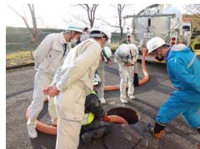
バキューム車による汚水運搬
