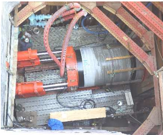
推進工法（開削しない方法）による雨水管きよ整備工事【福井市】
