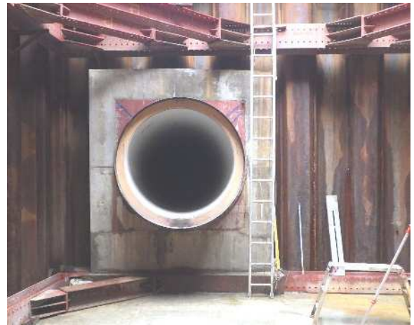
推進工法（開削しない方法）による雨水管きよ整備工事【福井市】
