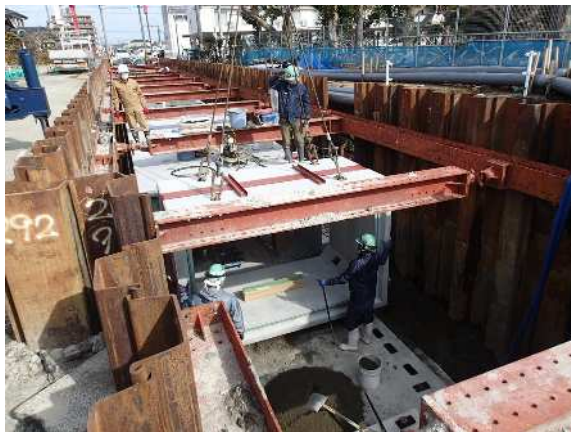
雨水管きよ（開削）整備工事【敦賀市】
