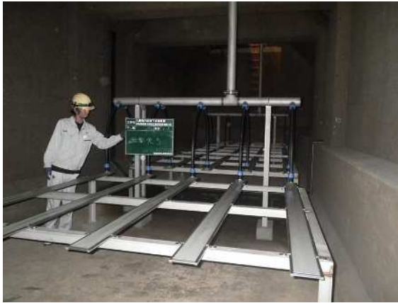
反応槽散気装置改築工事（左）、消化タンク改築工事（右）【九頭竜川流域下水道】
