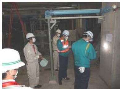
処理場の緊急点検
