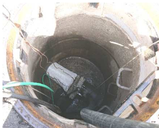
管更生（掘削せずに下水道を新しくする）工事【福井市】
