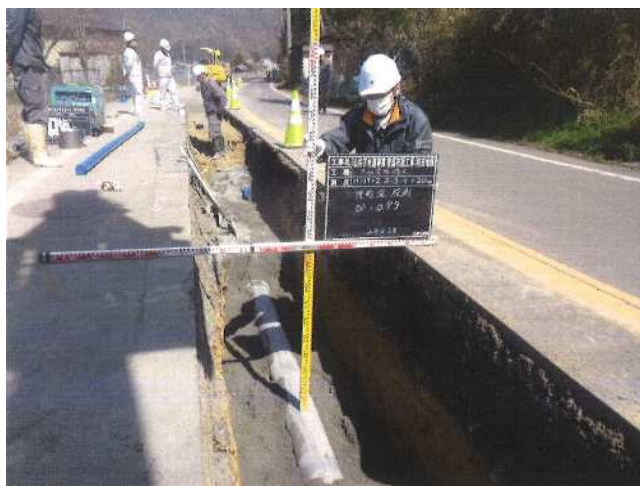
管敷設工事【高浜町】
