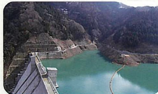
左岸展望台から見た河内川ダム
