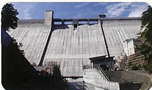
下流見学広場から見た河内川ダム
