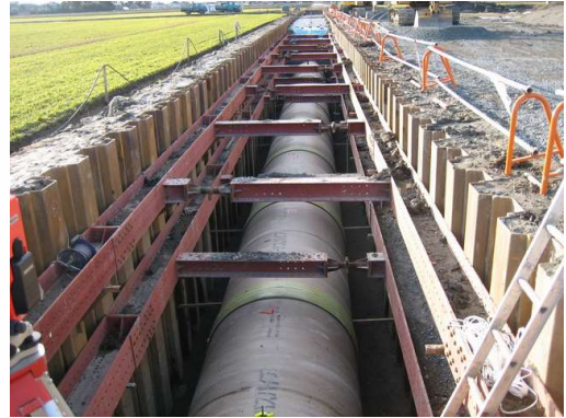
九頭竜川下流地区のパイプライン水路整備
