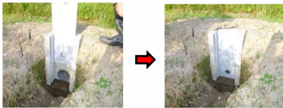
流量調整板の設置状況（左：設置前 右：設置後）
