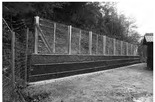
補強土壁工法（東黒田地区 若狭町東黒田）
