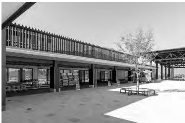
ウッドプラスチックのルーバー（大野市）
