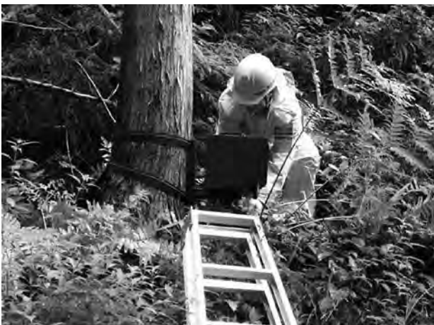
監視カメラの設置
