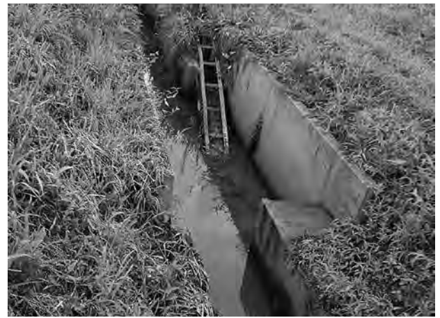
水田魚道の設置による水系の連続性の確保 (越前町)
