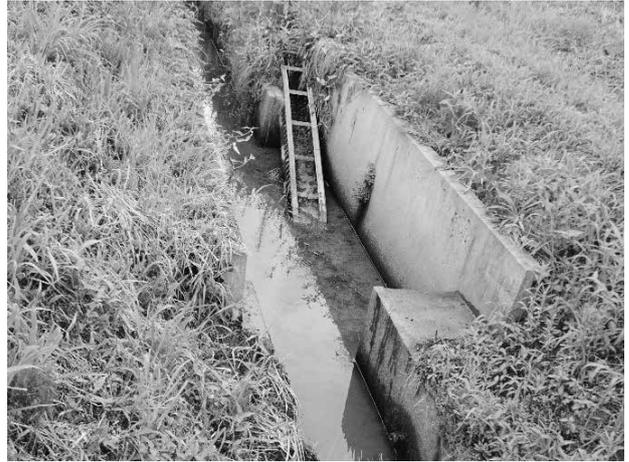
水田魚道の設置による水系の連続性の確保
