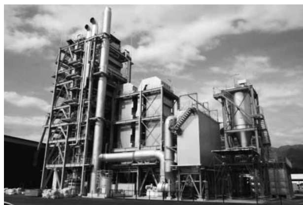
木質バイオマス発電施設（大野市）
