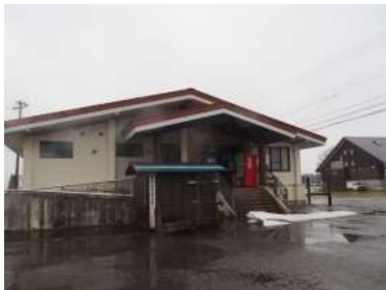
<サン・スポーツランド管理棟>
