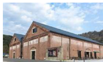
敦賀赤レンガ倉庫
