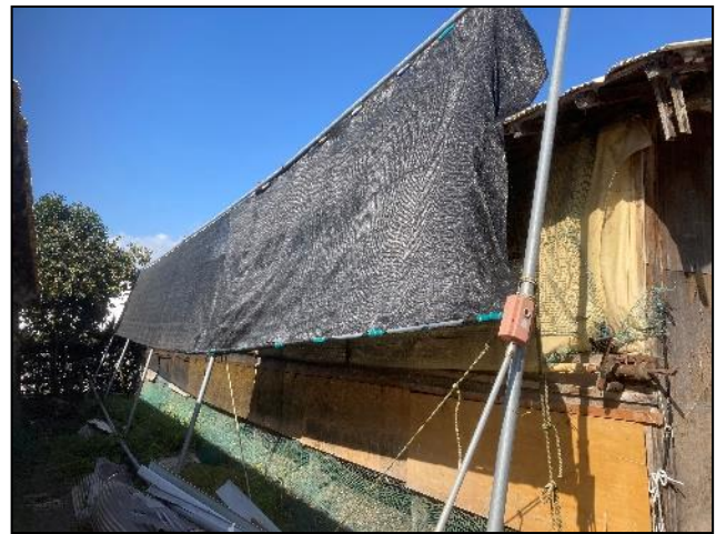
県内養鶏場の例（遮光ネット設置）
