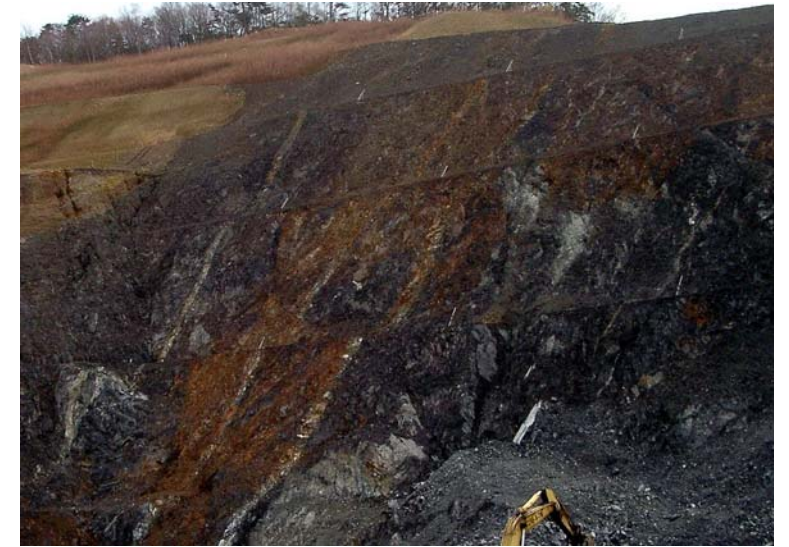
頁岩中に貫入するひん岩〔南側斜面掘削面〕
