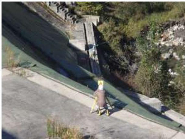
シートの変状などが無いかを点検
