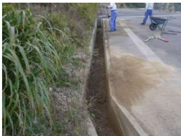
水路に堆積した土砂を除去し排水機能を回復
