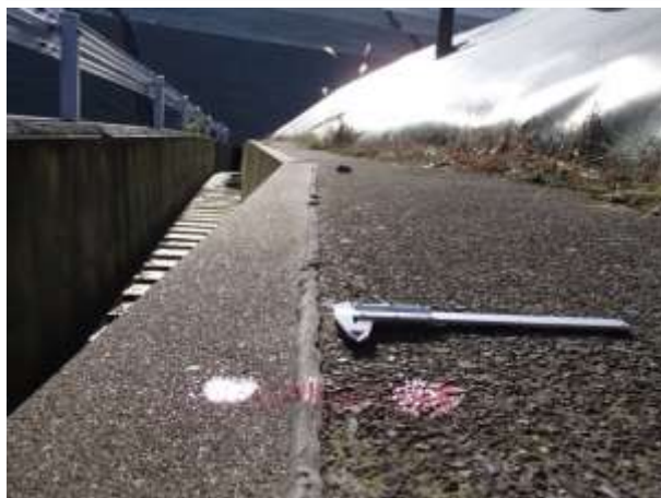
補修跡の変状を計測し、健全性を確認
