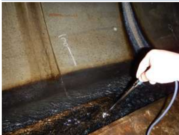
トンネル内の排水流量や流速などを測定し、遮水機能をチェック
