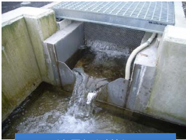
流量観測状況
