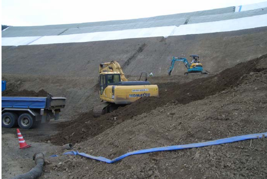
法面整形状況
