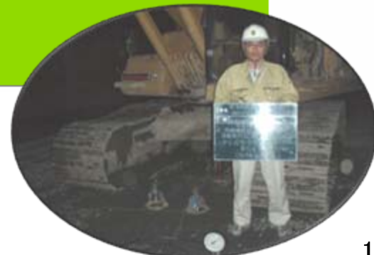
平板載荷試験状況
