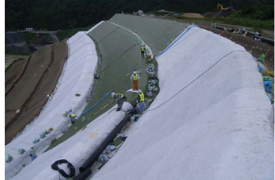
遮水シート敷設状況
