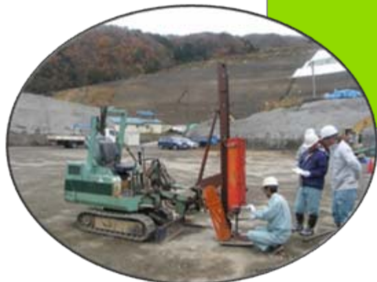
ラムサウンディング試験状況
