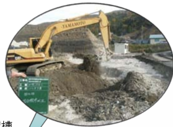
地盤改良施工状況
