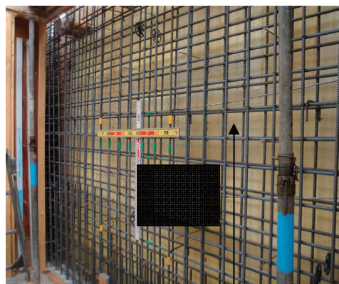
板状の部分が樹脂型枠
