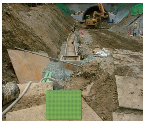
(B) 撤去したU字溝を再利用した仮設側溝
