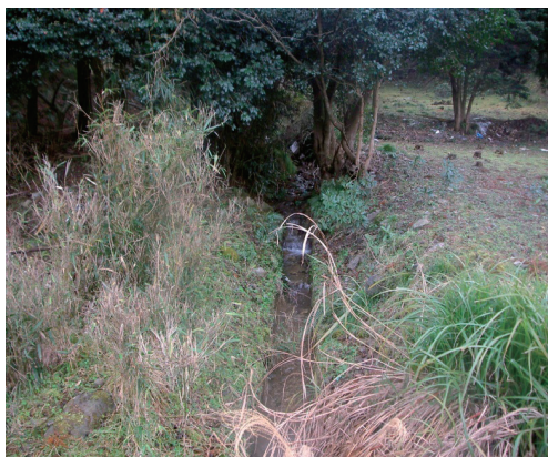
(A) 撤去したU字溝の施工前の状況
