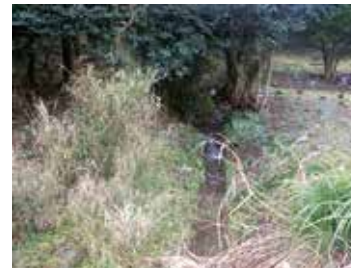
(A)撤去したU字溝の施工前の状況
