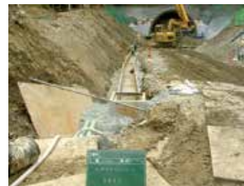
(B)撤去したU字溝を再利用した仮設側溝
