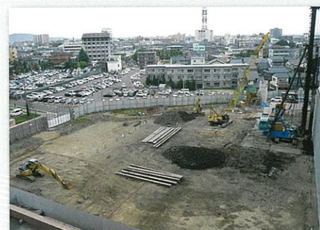
建設地での基礎工事
