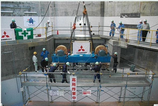
9月20日の治療装置の搬入・据付作業
