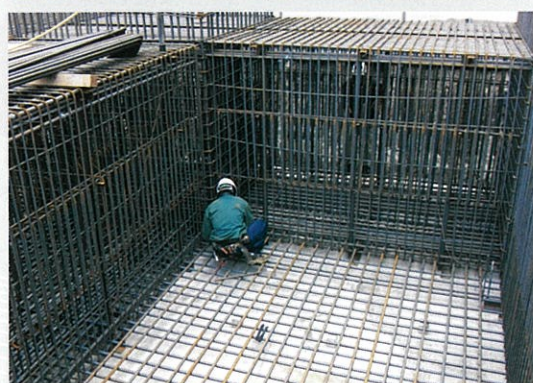
基礎工事が進められている建屋（平成21年2月末現在）
