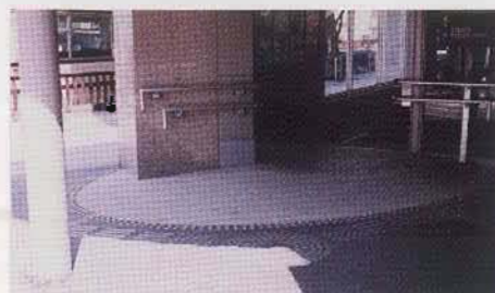
織協ビル前 出入口 段差解消
