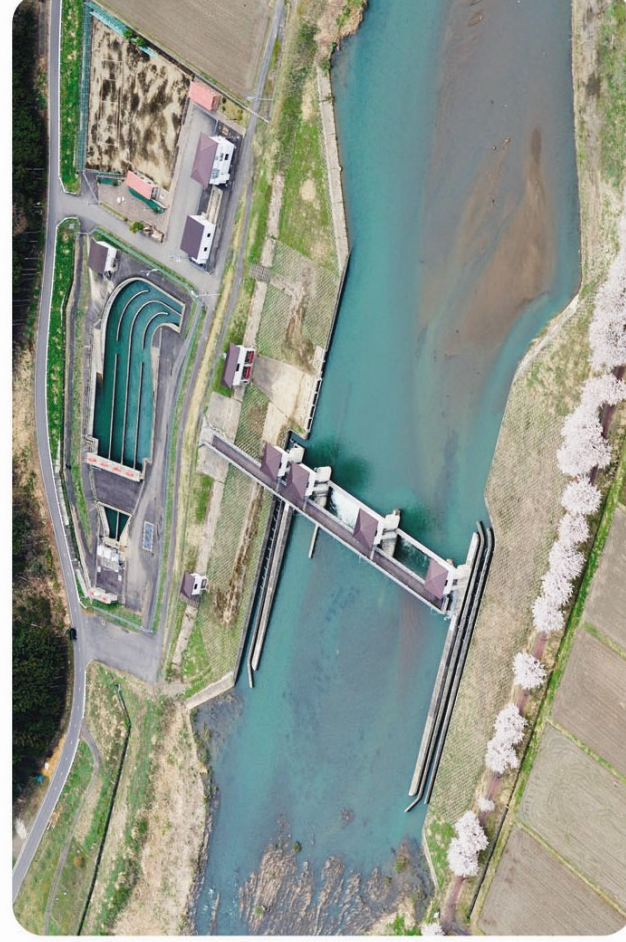
八乙女頭首工
