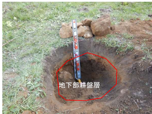
写真－７ 水田跡地の地下部耕盤の除去 （敦賀市試験地）
