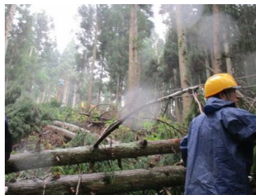
⑤ 架線を張り上げ架設完了
