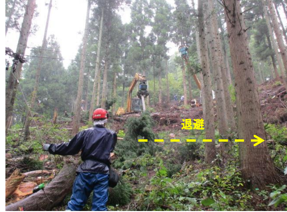
荷掛け完了後、安全な場所へ退避してから指示
