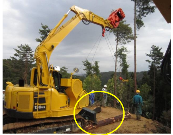
ブレードを下ろし丸太を敷いて安定させる
