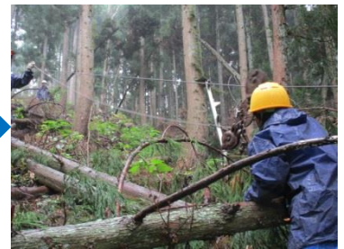
③ 引寄索とともに搬器を先柱へ移動
