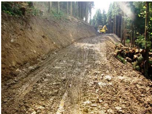
林道や作業道の伐開幅状況
