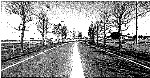
福井金津線に整備された消雪施設 (坂井市坂井町東長田「付近」令和4年11月撮影)
