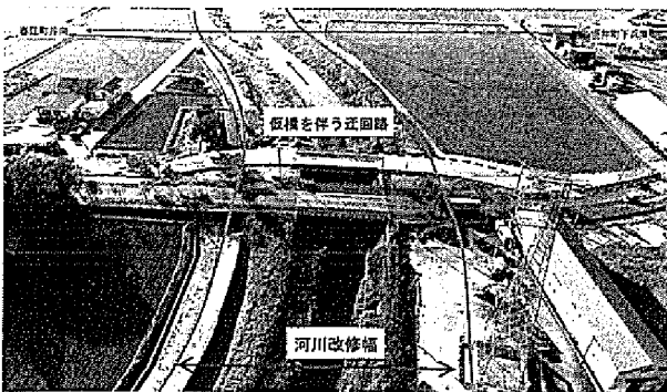
河道拡幅工事 芦原街道(新橋) 令和4年11月撮影
