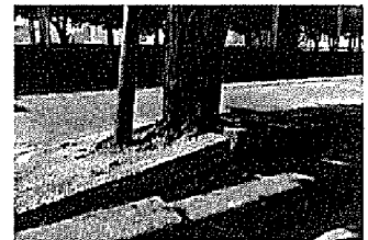
根上りによる植樹木の破損 (金津高校通学路)
