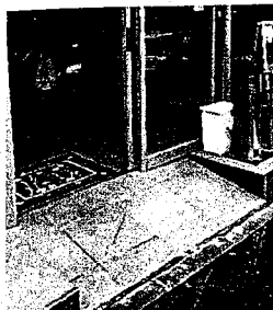
スロープの設置
