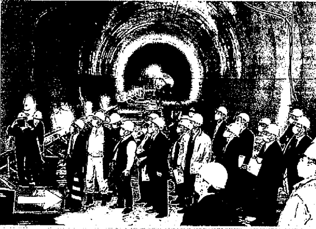
ひび割れが生じた加賀トンネルを視察する県議ら5日、石川県加賀市(福井県側)。(福井新聞社・提供)
