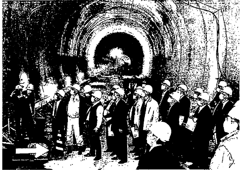
石川県加賀市(鈴木孝介撮影) ひび割れが発生した加賀トンネルを視察する県議ら5日、
