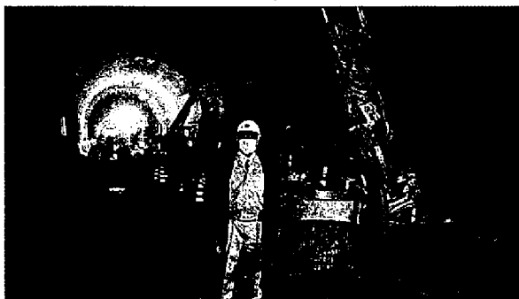
▲ヒビの入った加賀トンネルを補修する工事現場を視察
