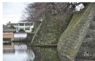
本丸西側の石垣の状況
