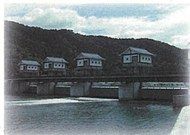
現在の足羽川頭首工
