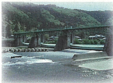
旧足羽川頭首工
