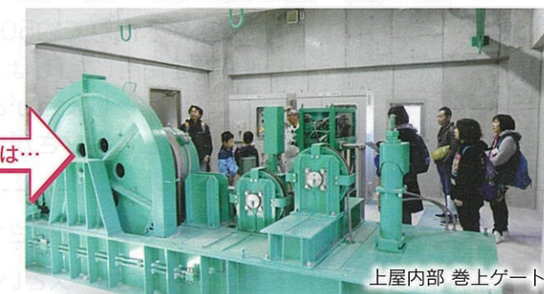
足羽川頭首工 管理通路
