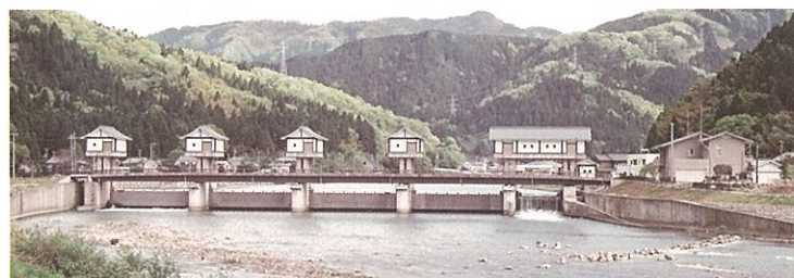
足羽川頭首工(福井市安波賀中島町)
