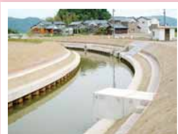
完成した排水路
