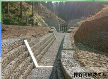
押谷川砂防ダム
